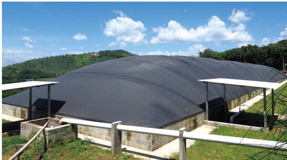
沼气池氧化塘 Biogas digester oxidation pond
